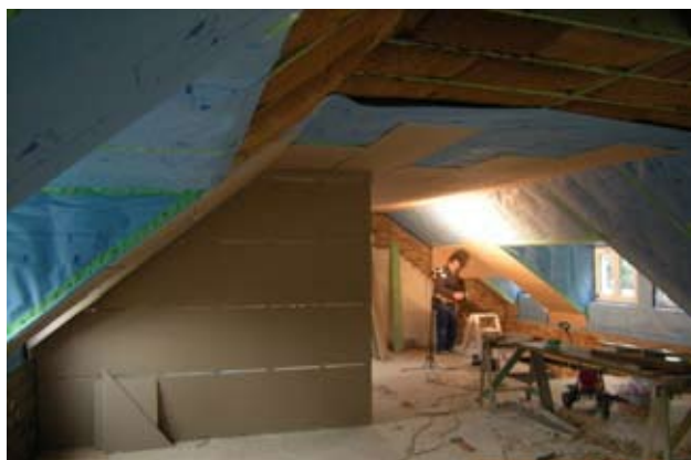
Isolation de la toiture et pose du freine-vapeur. Les différents éléments sont raccordés par des bandes adhésives étanches.
