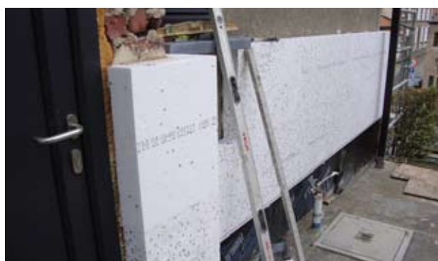
Isolation des façades en panneaux de polystyrène expansé. Isolation des soubassements en panneaux de verre cellulaire.
