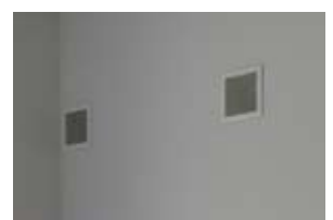
Arrivées d'air chauffé par le poêle.
