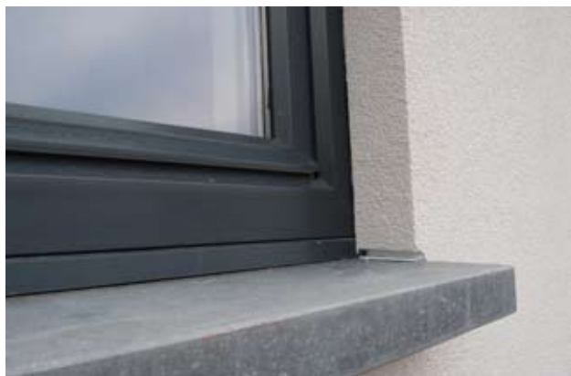
Panneaux d'isolation posés devant châssis + crépis.
